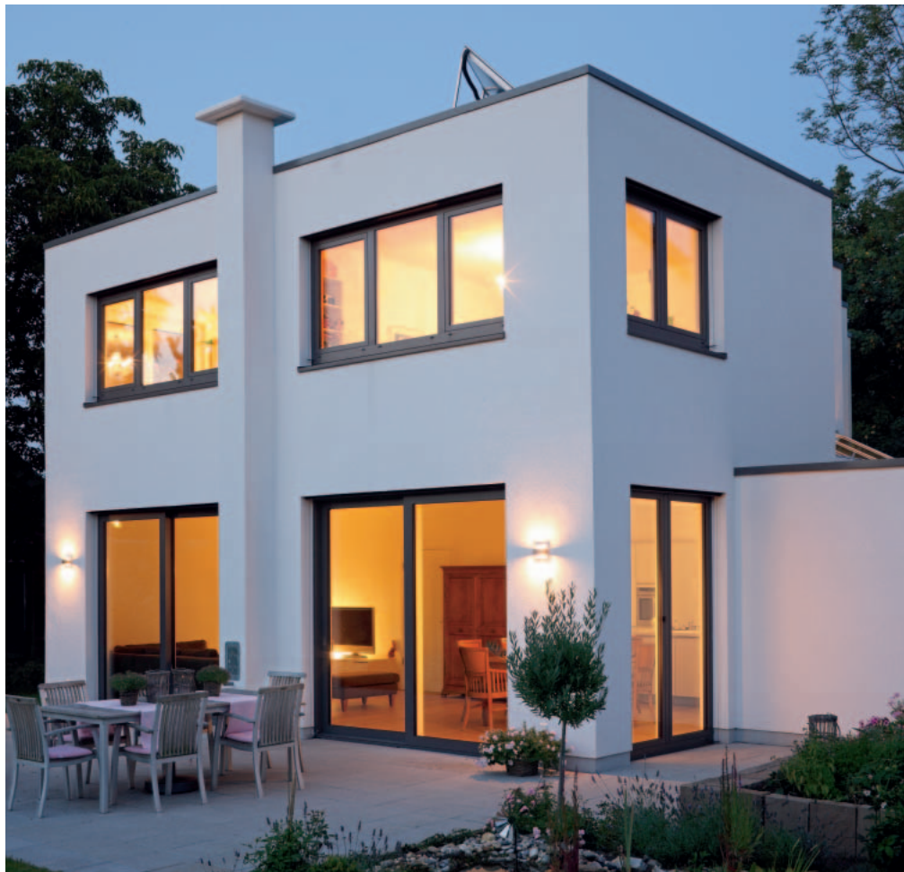
Einfamilienhaus mit Sole/Wasser-Wärmepumpe und Solarthermie
