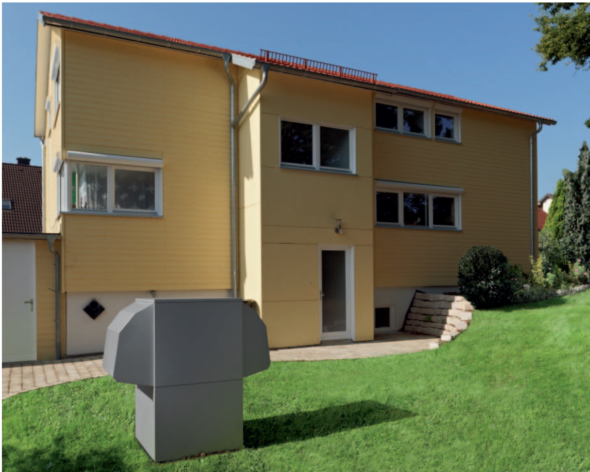
Einfamilienhaus mit Luft/Wasser-Wärmepumpe
