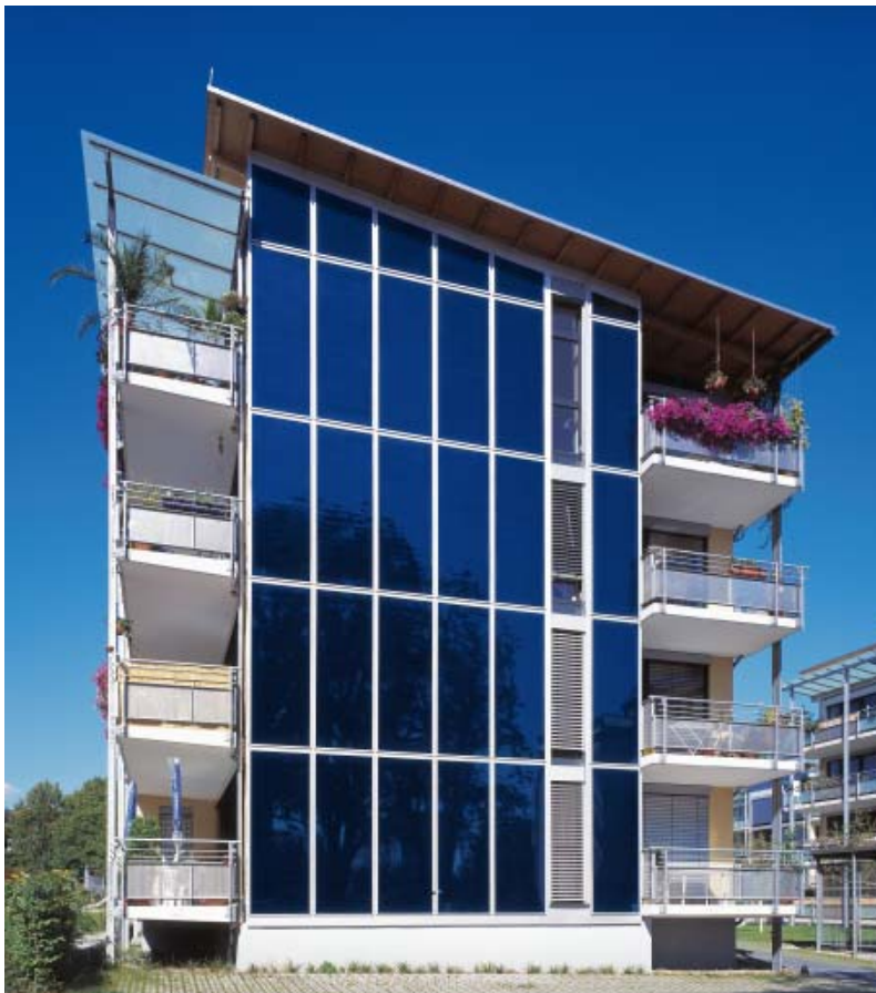
Mehrfamilienhaus mit Fassadenmontage
