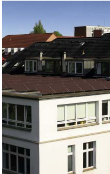
Flachdachanlage mit Dünnschichtmodulen
