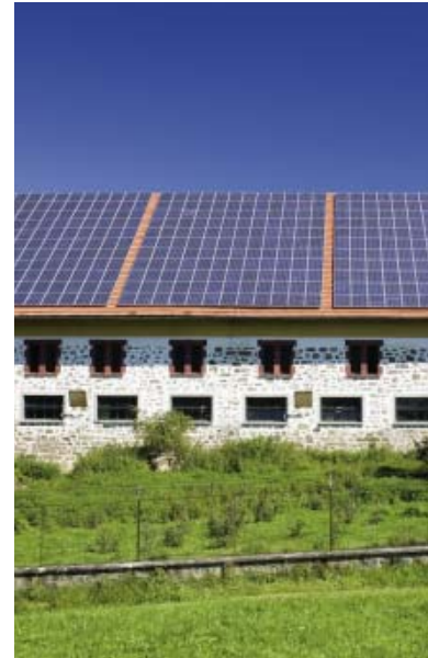
Aufdachanlage mit polykristallinen Modulen
