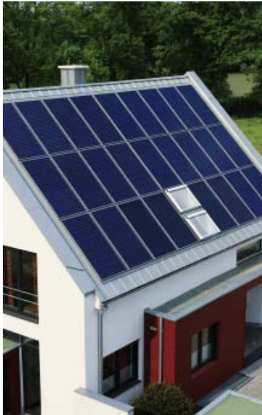
Indachanlage mit kristallinen PV-Großmodulen der Premium-Linie
