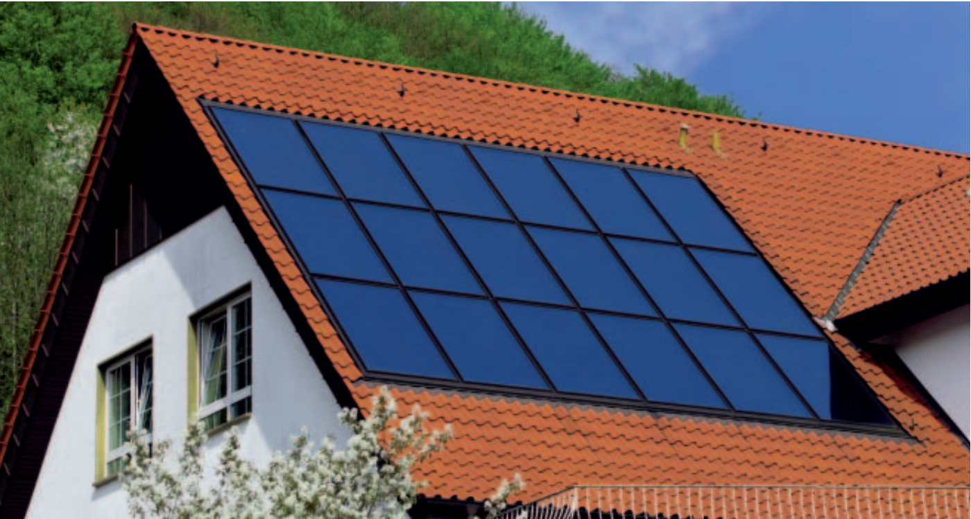
Solaranlage mit Indachmontage
